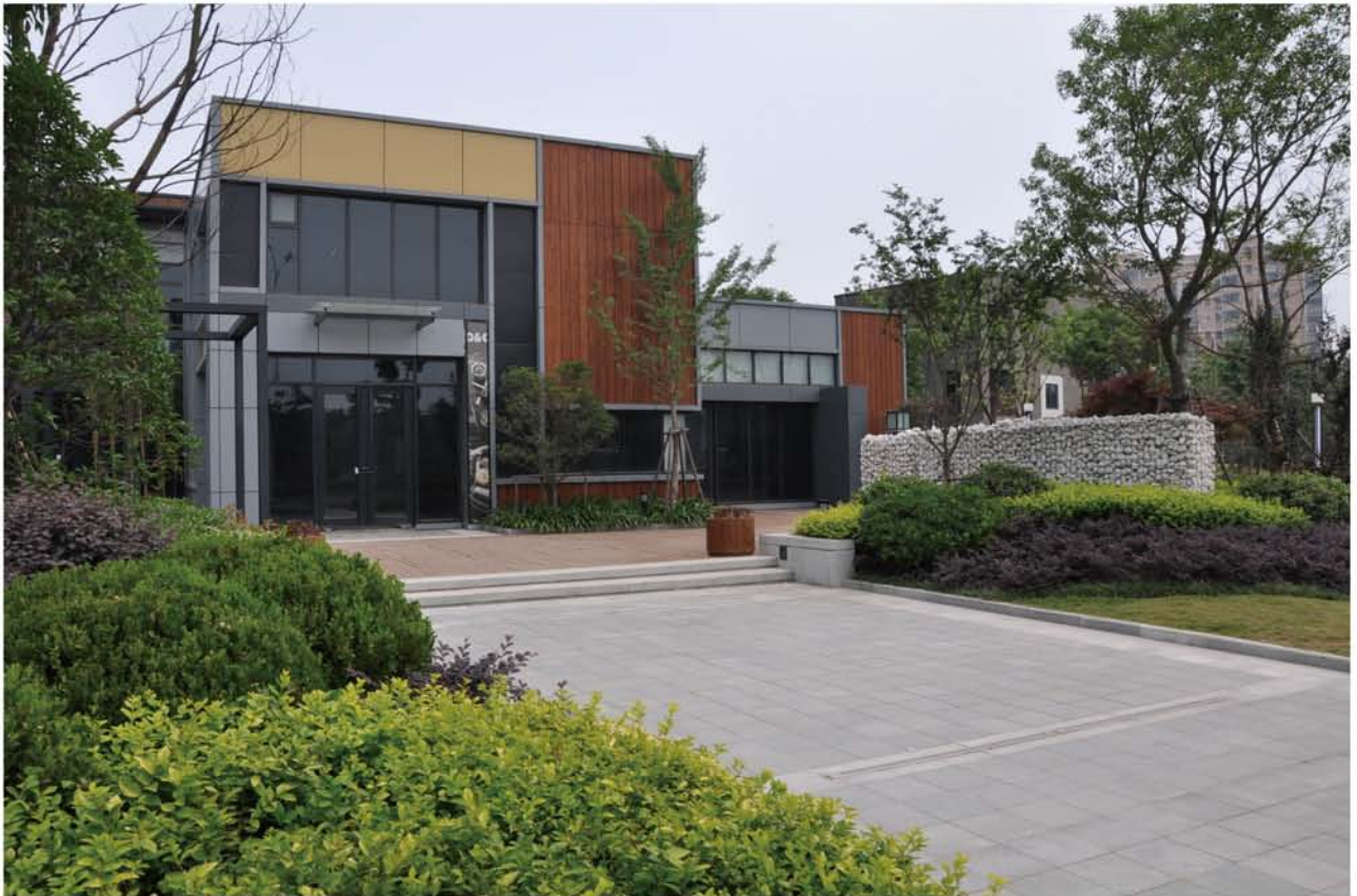
茂华集团淮安国际汇南昌路商业街实景照片
